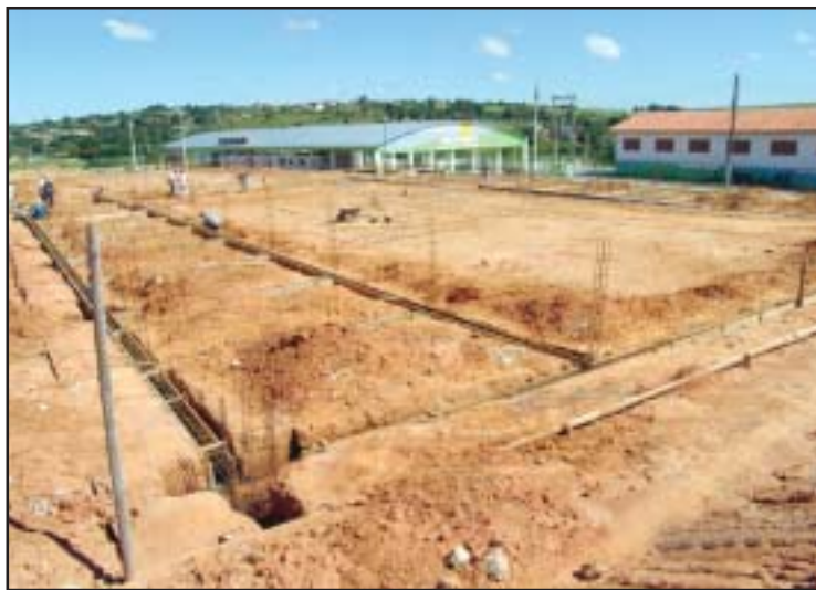
Local onde deverá ser instalada a praça de alimentação
