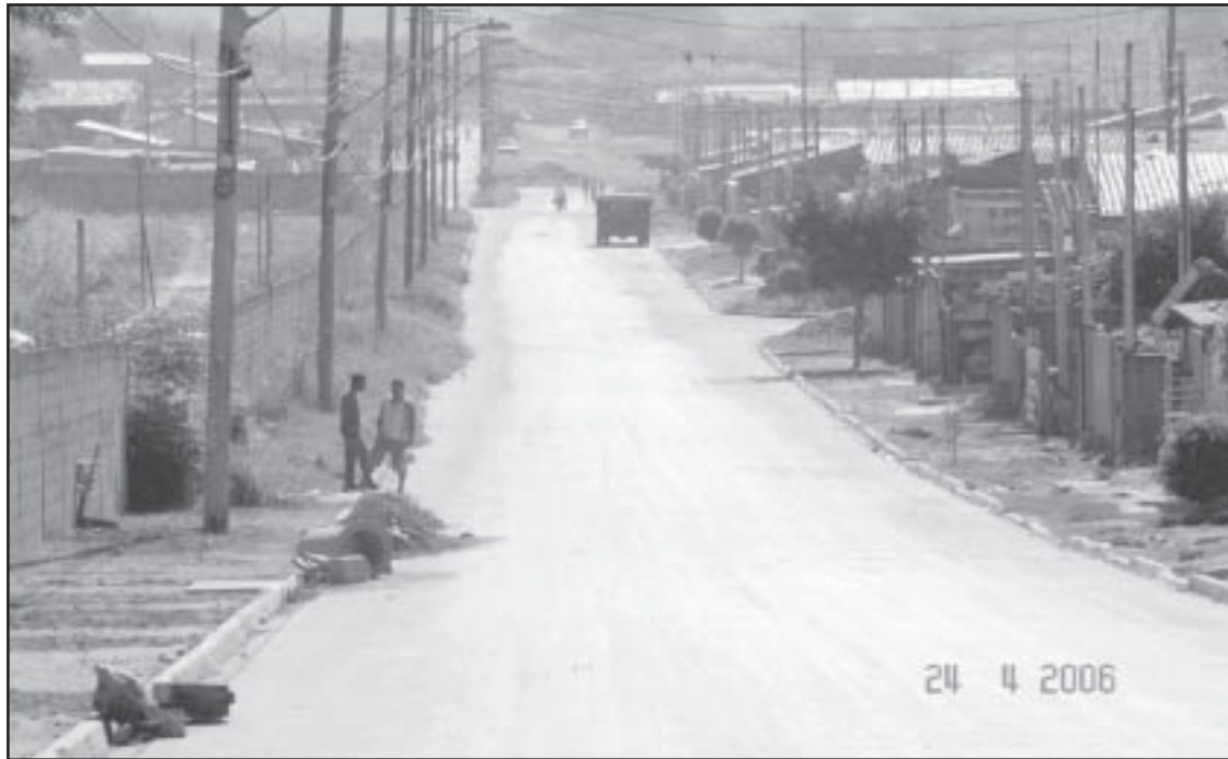
Os serviços de pavimentação asfáltica na rua Juvenal Leme dos Santos estão concluídos
