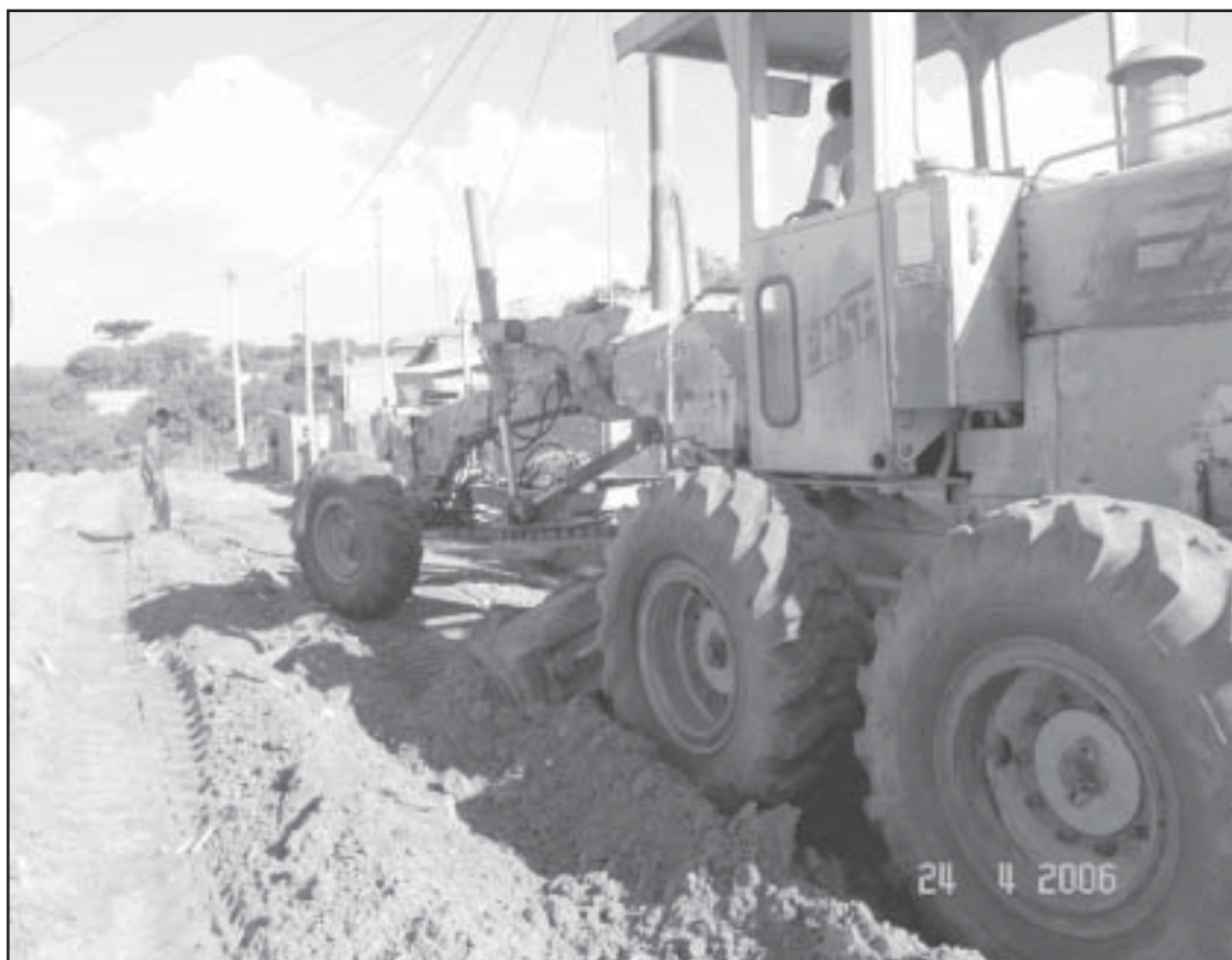
Preparação da rua Emiliano Juvino de Almeida para receber a pavimentação asfáltica
