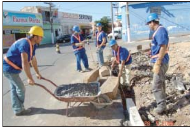
Prosseguem as obras nas calçadas do Centro
