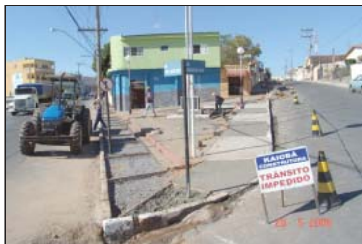
Obras iniciadas na rua Francisco de Barros Leite
