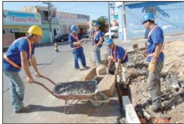
Prosseguem as obras nas calçadas do Centro
