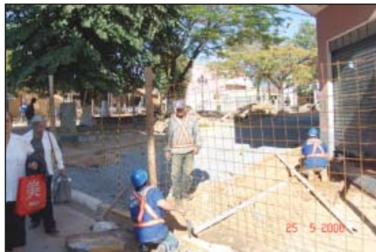
Praça Francisco Pedroso de Brito sendo preparada para receber novo piso
