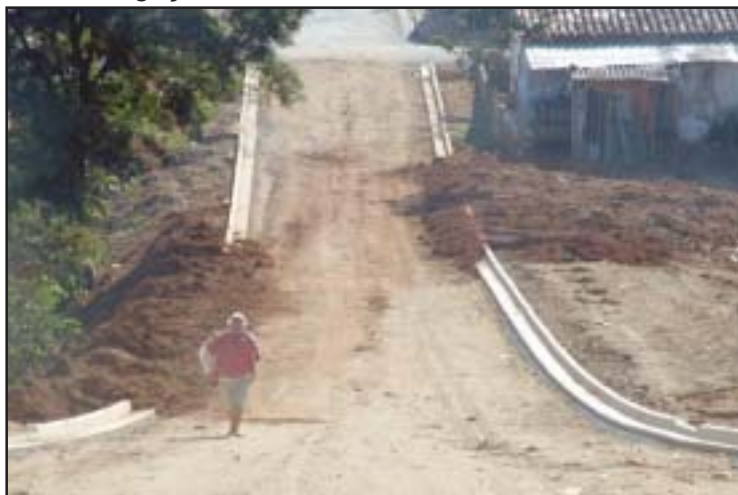
A interligação entre as ruas Rio de Janeiro e Esp. Santo
