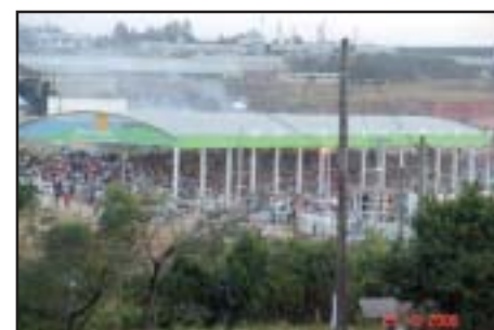
Vista panorâmica de parte do recinto
