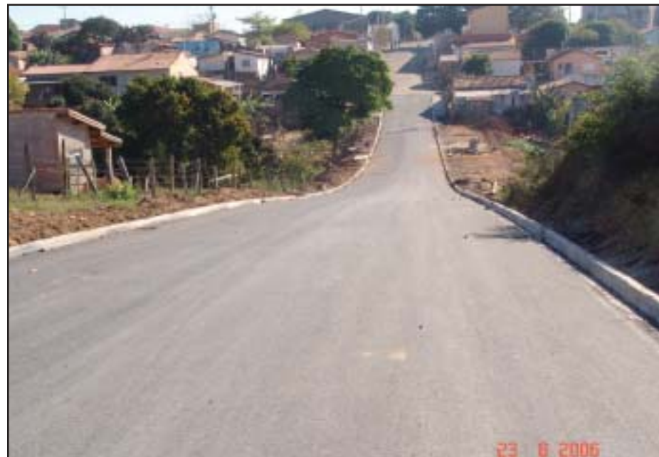
A rua Paraná, hoje, pavimentada e interligando outras vias
