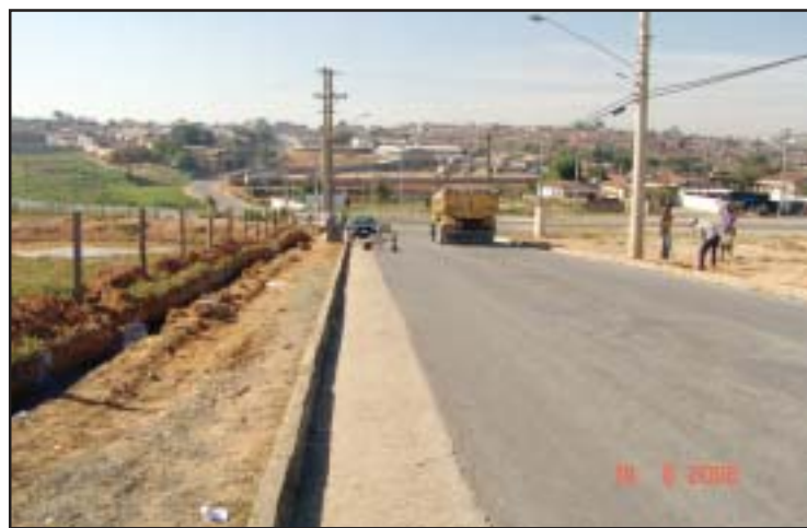
Antes, a rua Petrônio Portela sem calçada concretada
