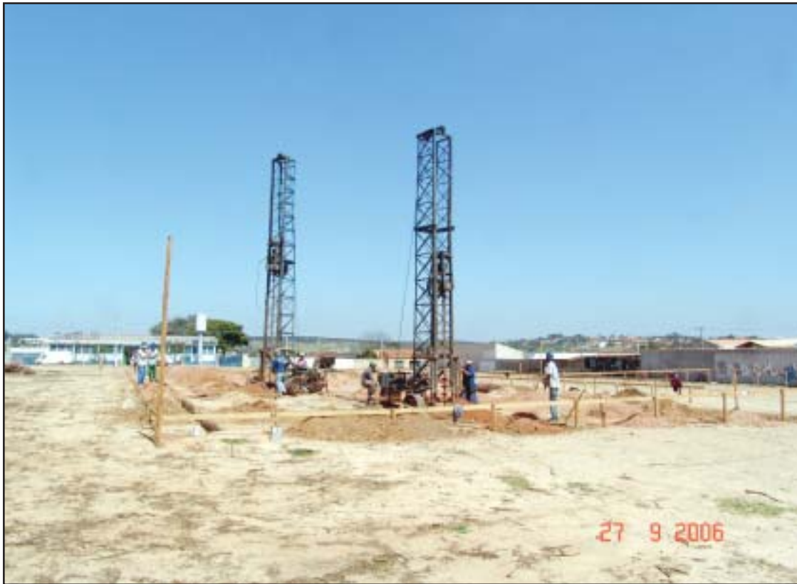
Obras da nova escola especial, que está sendo construída em área central da cidade
