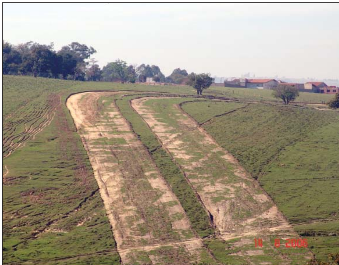
Nova avenida que interligará o Campo Largo ao Distrito Industrial faz parte do plano
