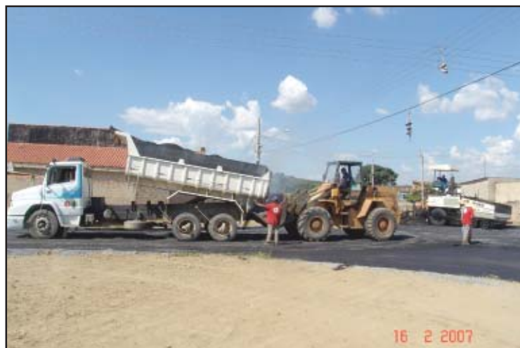
Homens e máquinas nos serviços de pavimentação
