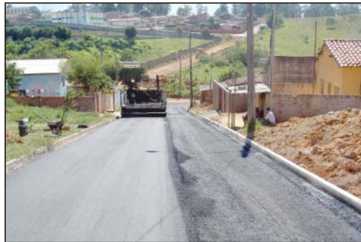
Jardim Madalena já está recebendo o asfalto
