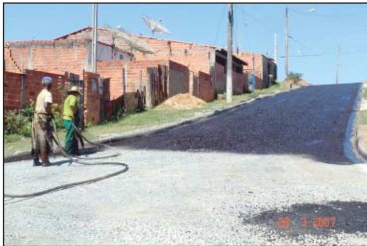
Ruas do Madalena sendo preparadas para o pavimento
