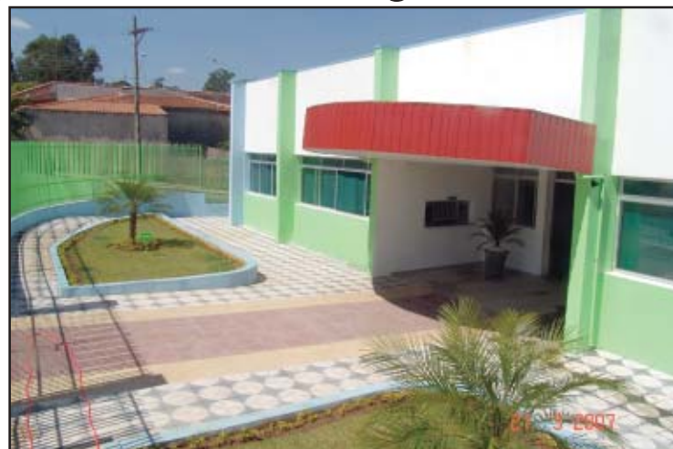
Hoje: Obra concluída e sendo entregue à população
