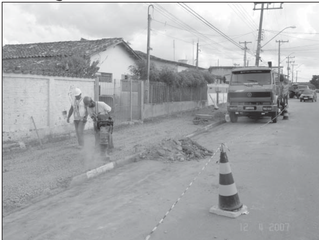
Nesta etapa, serão aplicados 7.830 metros quadrados de pisos nas calçadas
