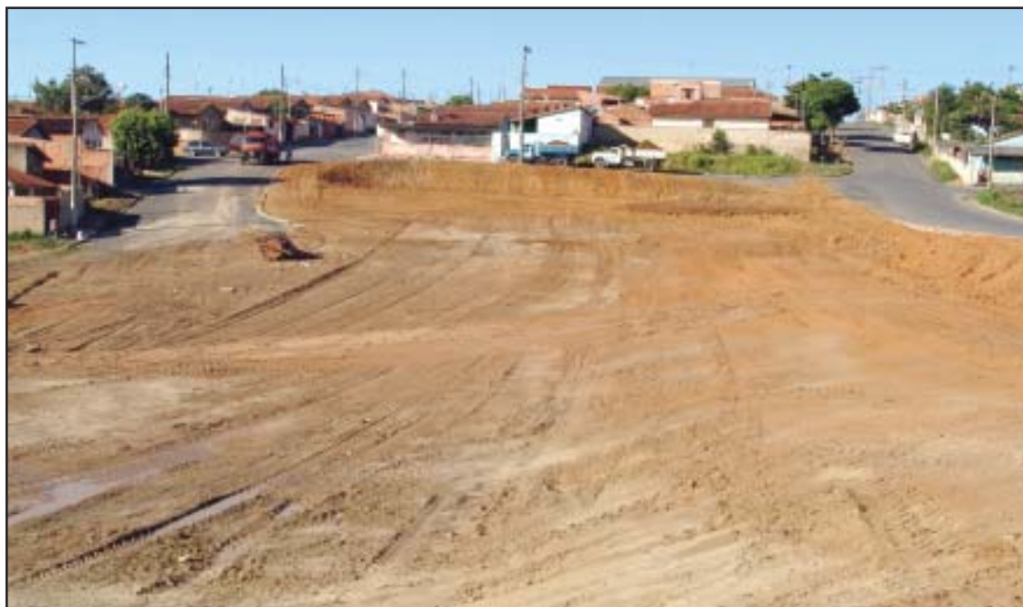
Área de lazer do Jardim Madalena já recebe os primeiros serviços de infra-estrutura
