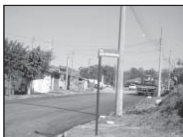
Serviço incluiu sinalização
