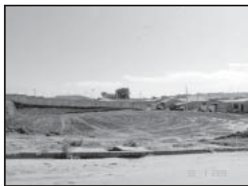
Área sendo preparada
