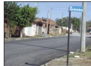
Serviço incluiu sinalização nas ruas
