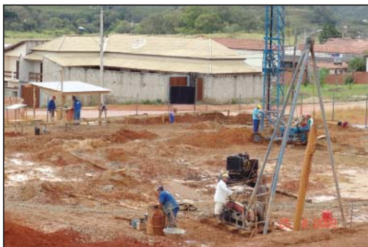
Prosseguem as obras da construção da escola municipal do Jardim Maria Clara para alunos do ensino fundamental
