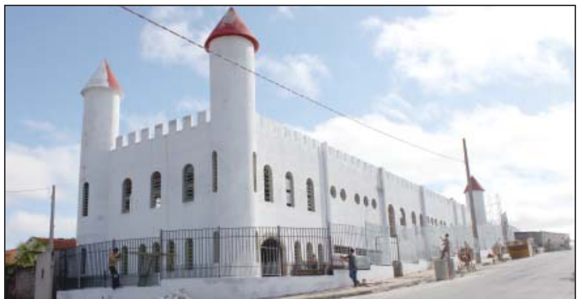
Projeto de engenharia da unidade chama a atenção pelas suas características
