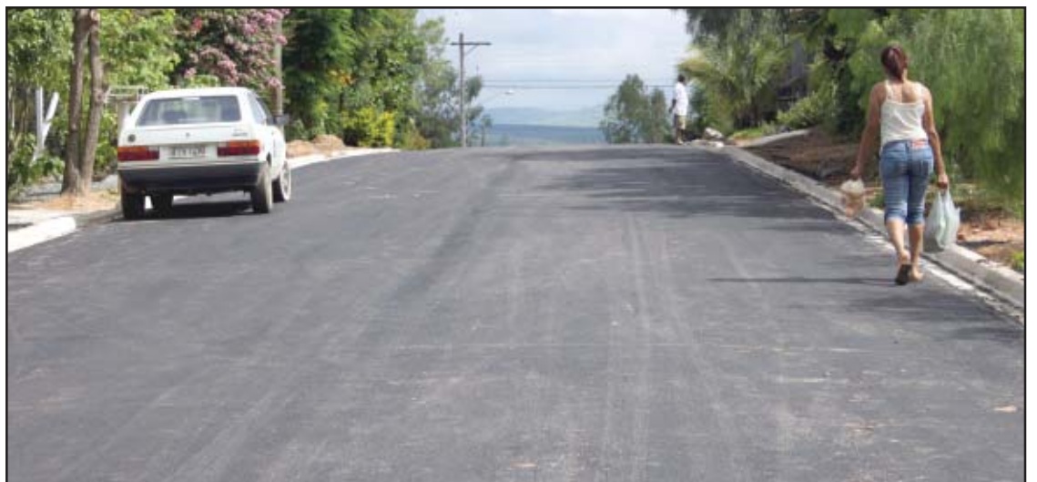
As ruas do São Manoel já estão recebendo o asfalto
