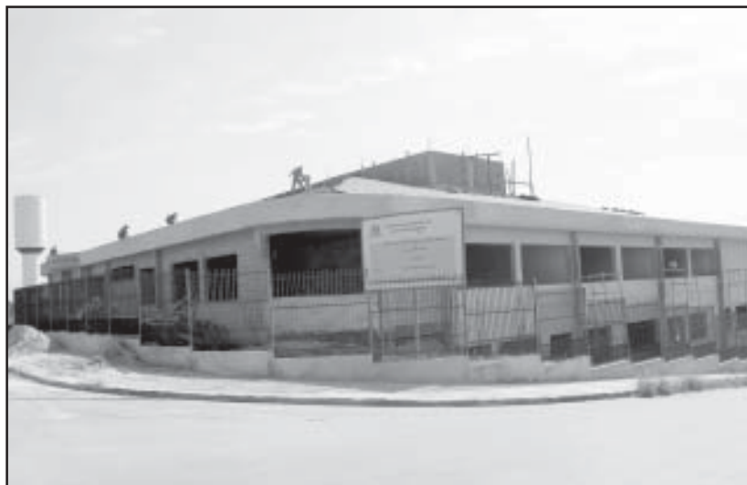
Obras prosseguem em ritmo acelerado
