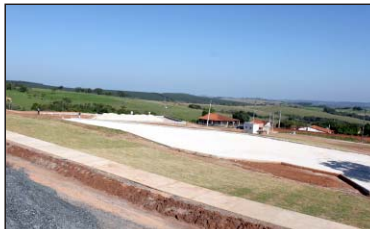
Prosseguem em ritmo acelerado as obras no São Manoel
