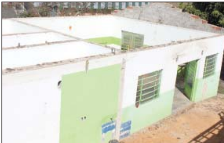
A creche está sendo totalmente reestruturada
